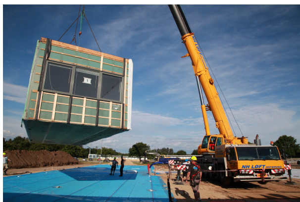
Opførelse af pavillonbyggeri.
