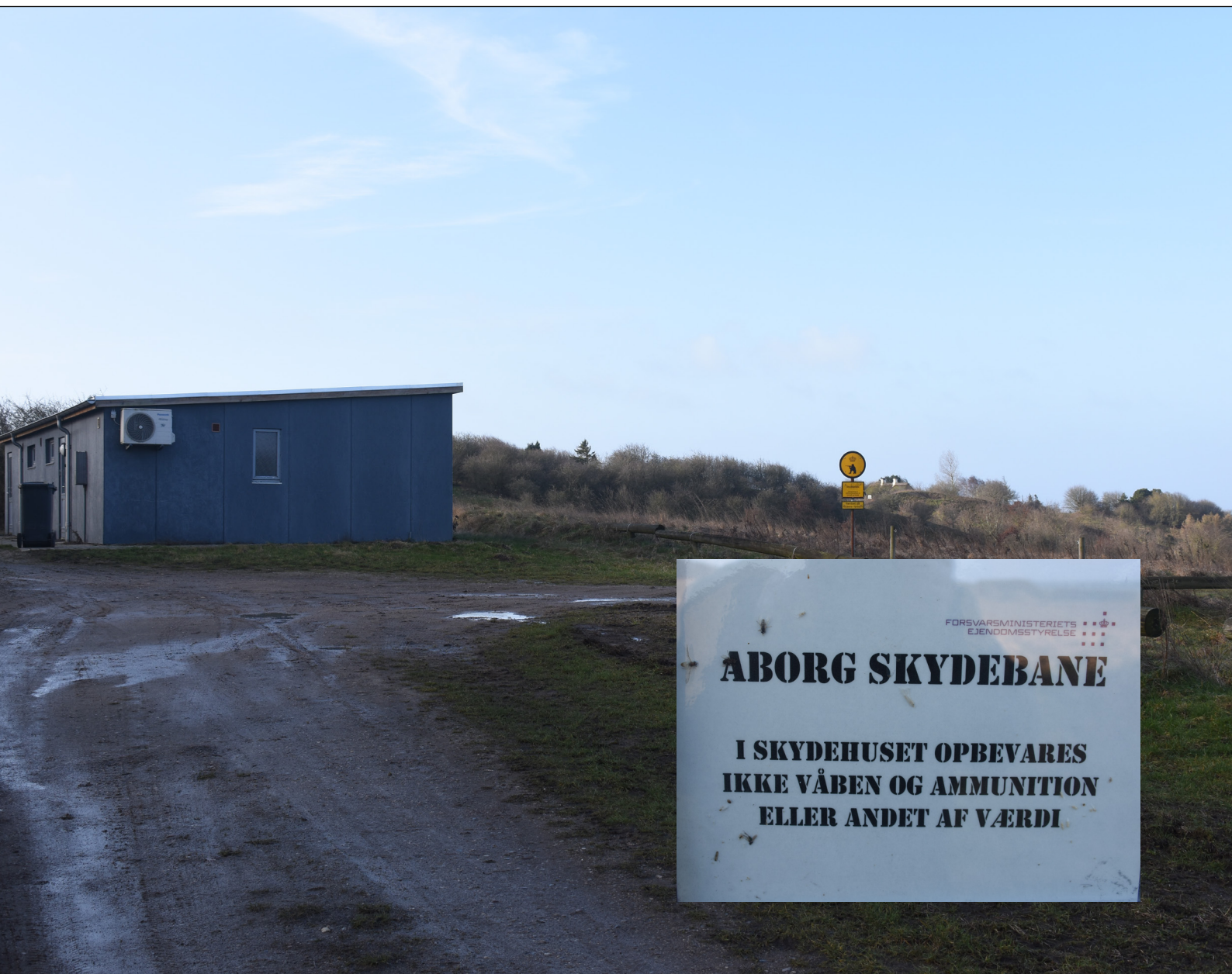
Bygningspavillonen på Aborg Skydeterræn.
