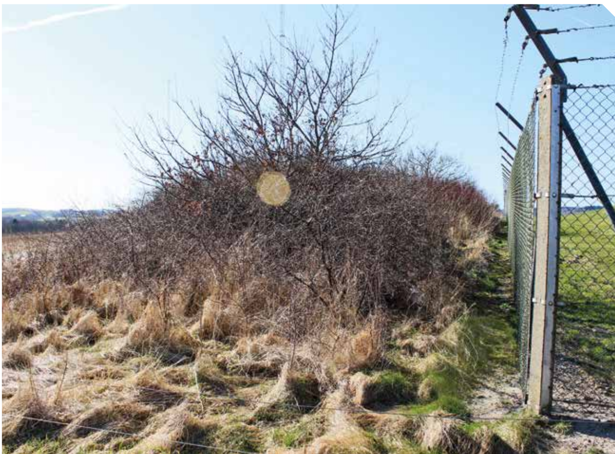
Opvækst langs perimeterhegn ind mod Maritimt Overvågningscenter Nord.
