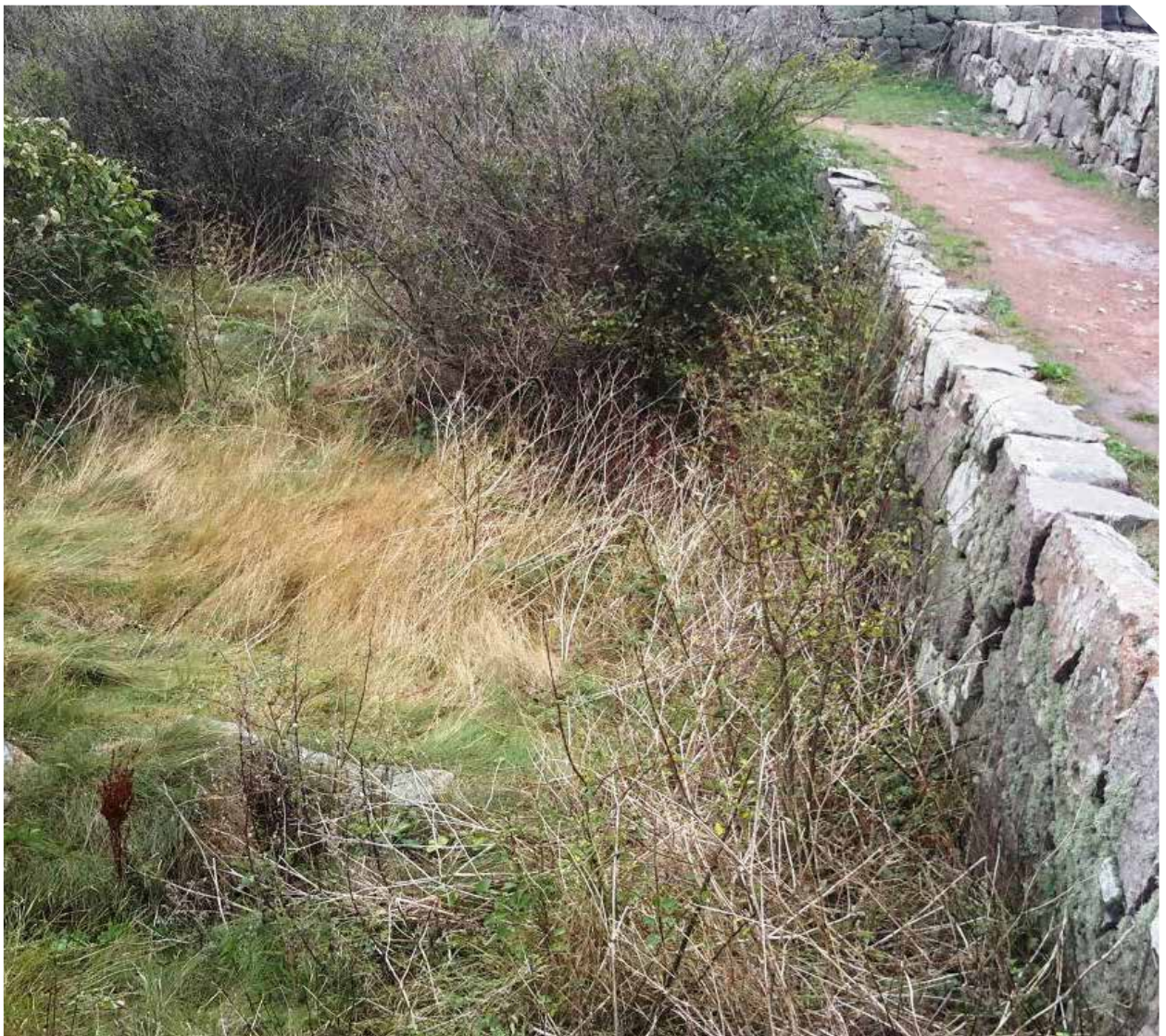
Tilgroning med vedplanter langs murværket kan være med til at destabilisere og fremskynde nedbrydning.
