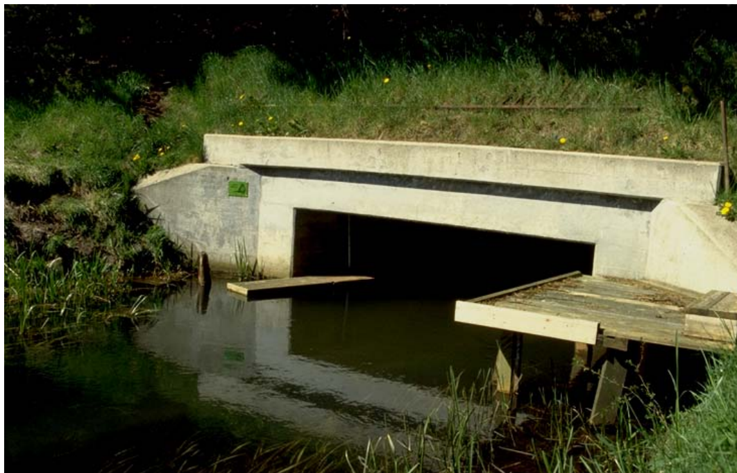
Viborg Amts faunapassage for odder i form af en flydende træpontonbro under Hovedvej A 16. Foto: Erling Krabbe, Skov- og Naturstyrelsen.
