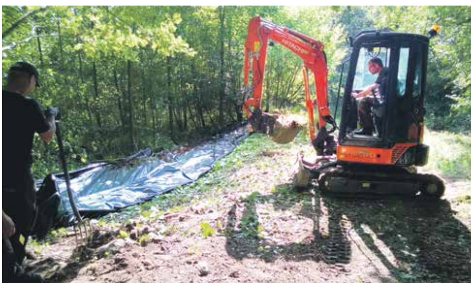
Kraftig, sort plastic lægges over området, hvor den japanske pileurt er fjeldet og gravet op.
