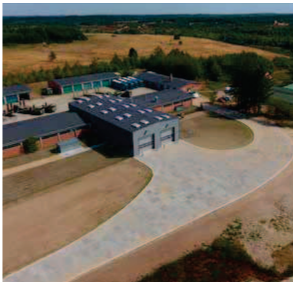
Det nye garageanlæg skærer sig igennem den gamle bygningsmasse og har nem adgang via store porte i begge ender af bygningen.
